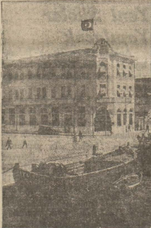
İzmirde liman ve rıhtım genel müdürlük binası
